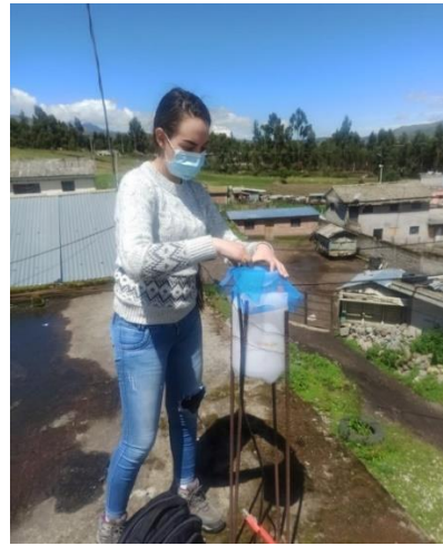
Figura 28: Mantenimiento colector Pulingui.
