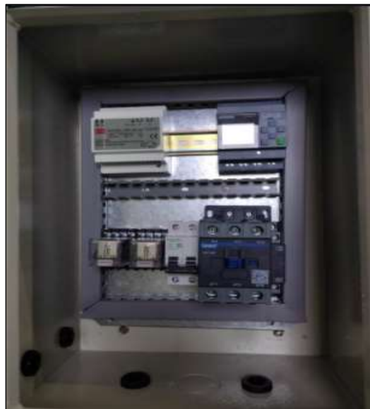
Figura 21-3: Montaje de los elementos dentro del gabinete
