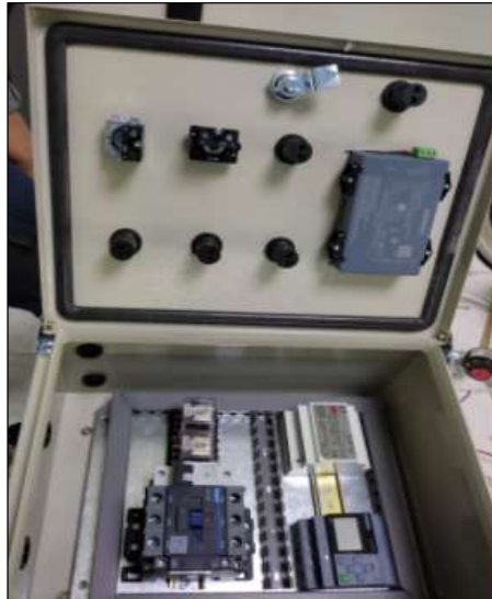
Figura 22-3: Montaje y fijación de elementos en el gabinete
