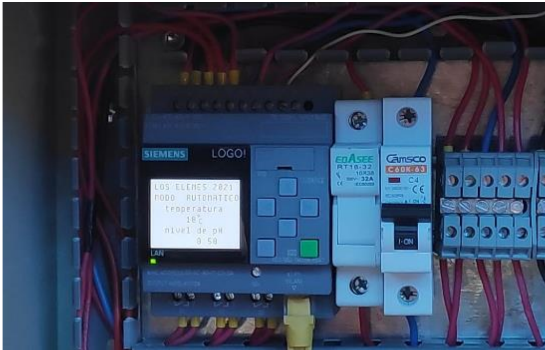
Figura 12-3: Visualización de datos en la pantalla del PLC
