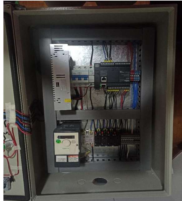
Colocación de la bandeja dentro del tablero de control
