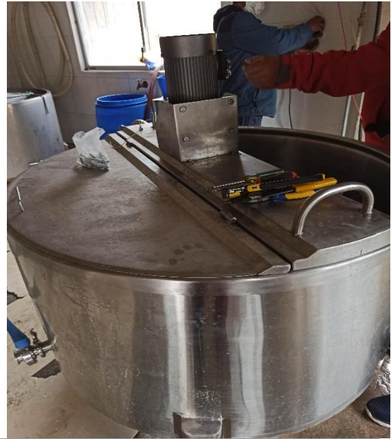
Instalación de las modificaciones y motorreductor a la olla pasteurizadora
