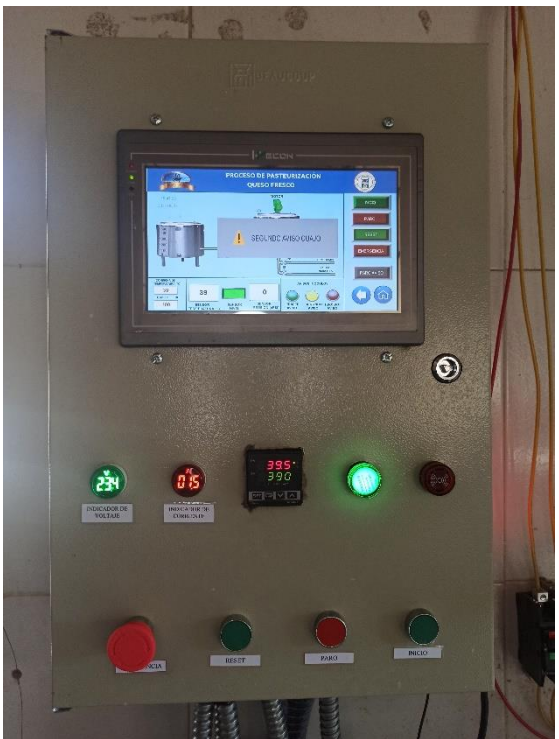
Segundo aviso para agregar cuajo (39,5°C)
