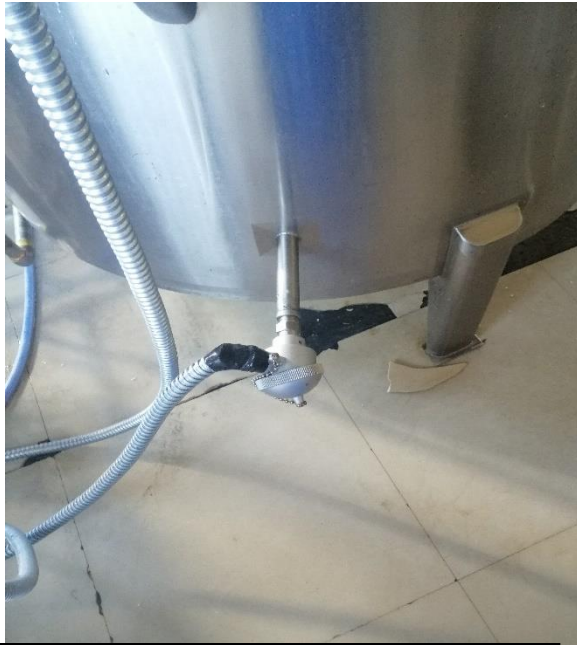
Instalación del sensor de temperatura PT100
