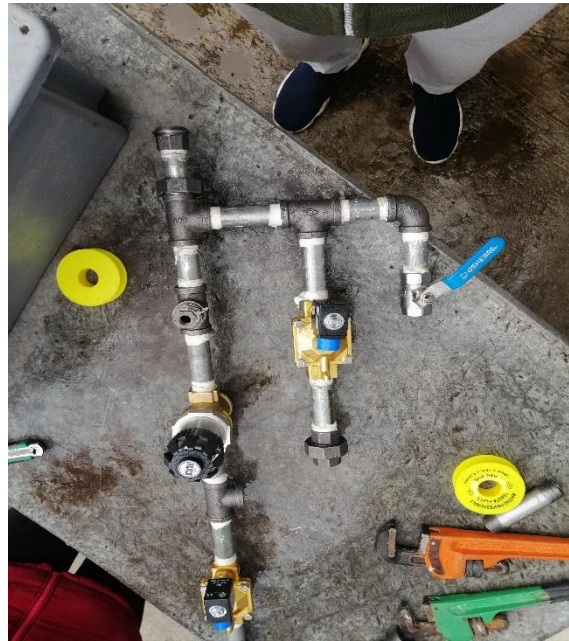
Conexión de las electroválvulas, válvula reductora de presión y trampa de vapor
