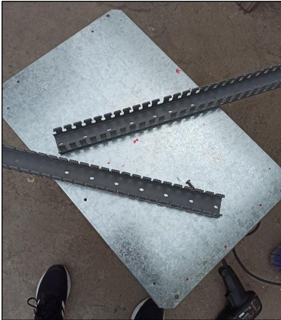
Perforación y colocación de canaletas ranuradas en la bandeja del tablero de control
