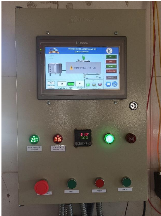
Primer aviso para agregar fermento (51°C)
