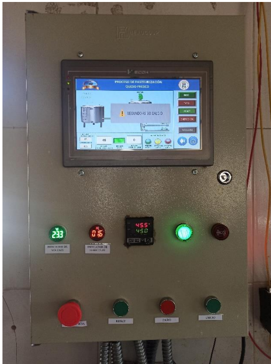
Segundo aviso para agregar calcio (45,5°C)
