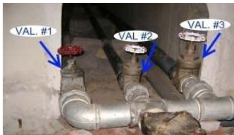
FIGURA 27. Válvulas de la succión del sistema
