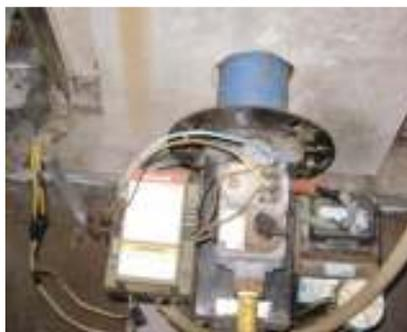
FIGURA 21. Quemador del calentador actual
