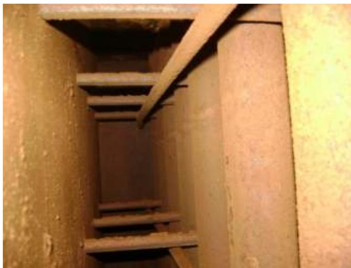
FIGURA 34. Corrosión y óxido de los calentadores actuales
