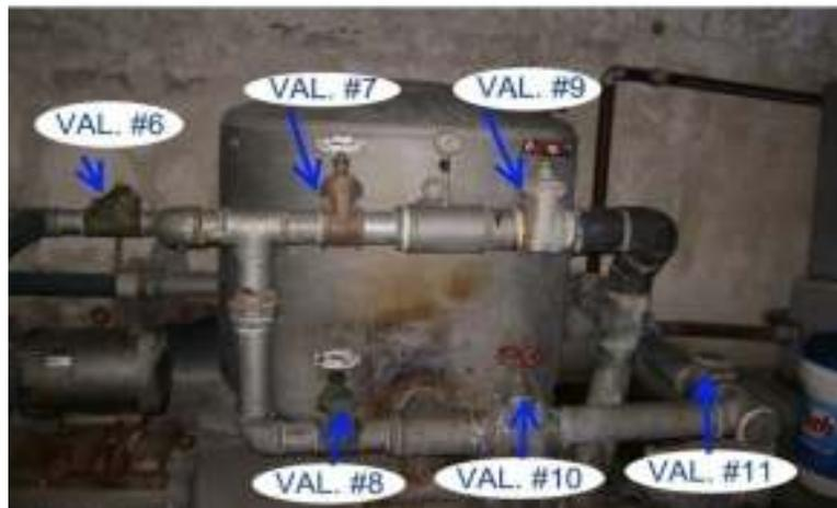
FIGURA 29. Válvulas 7, 8, 9, 10, 11 del sistema
