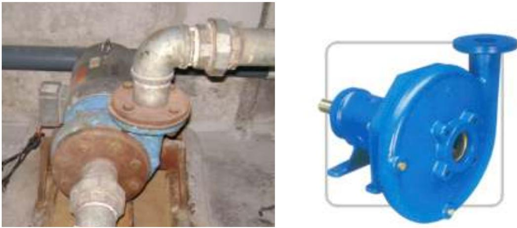
FIGURA 26. Bomba de agua centrifuga del sistema actual
