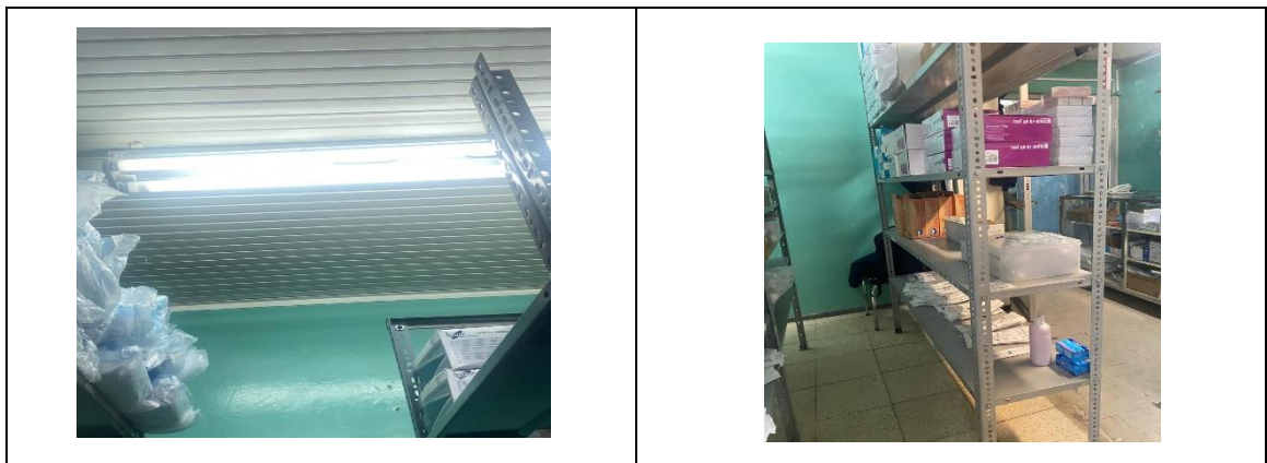
Ilustración 12-4: Intervención en la infraestructura de farmacia
