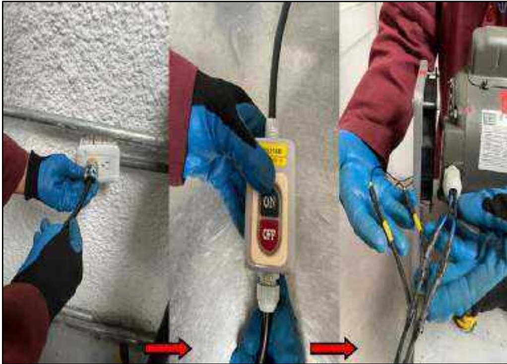
Ilustración 20-4: Verificación del correcto funcionamiento motor eléctrico
