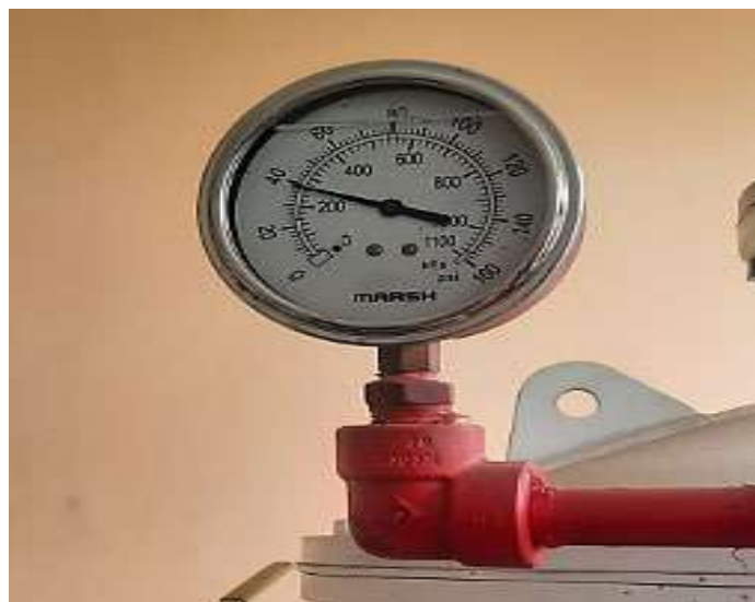
Ilustración 4-5: Manómetro de presión de la caldera
