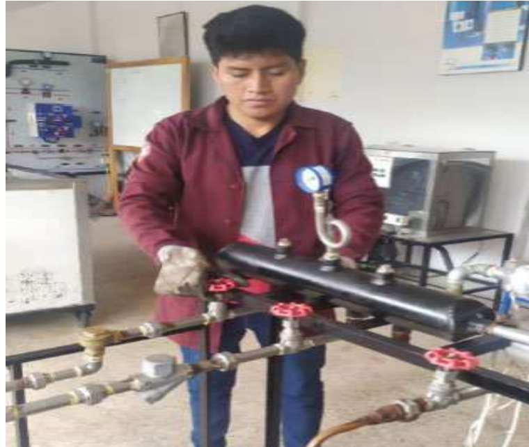
Ilustración 4-28 Válvula de compuerta del tramo 4
