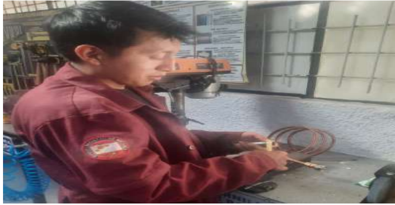
Ilustración 3-8: Aplicación de cinta de teflón en los elementos
