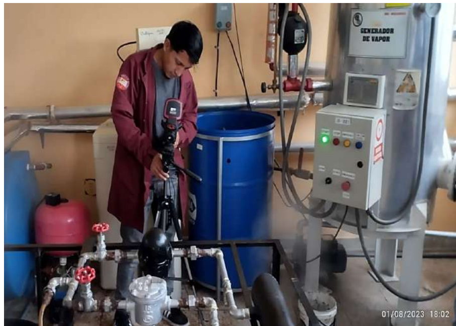
Ilustración 4-17: Pruebas de termográfica en el tramo 2
