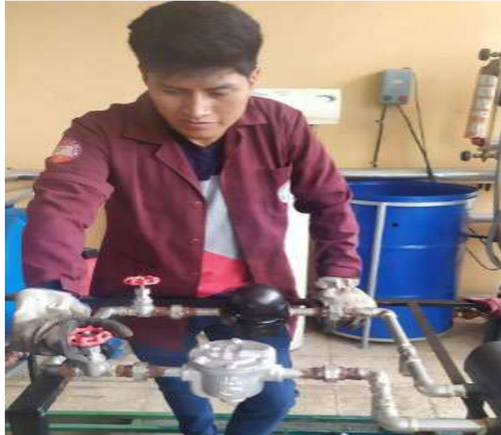
Ilustración 4-16: Válvula de compuerta del tramo 2 abierta
