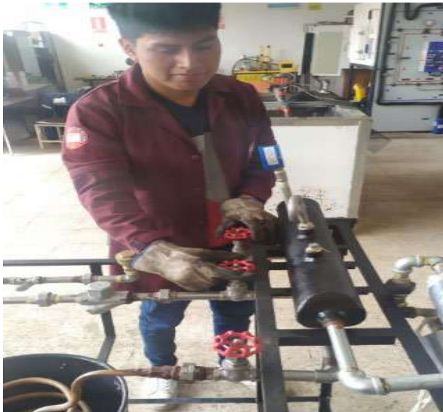
Ilustración 4-9: Válvula de compuerta del tramo 2,3 y 4 cerradas
