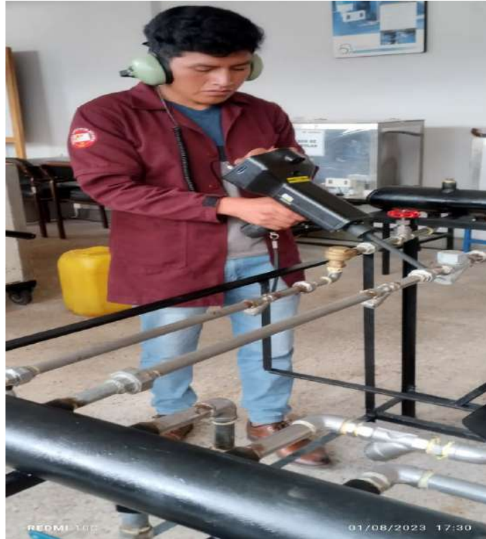
Ilustración 4-24: Pruebas de ultrasonido en el tramo 3
