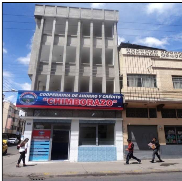
Oficina actual de la COAC "Chimborazo" Ltda., agencia Riobamba
