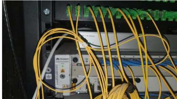
**Figura 43-3:** Conexión OLT y ODF
