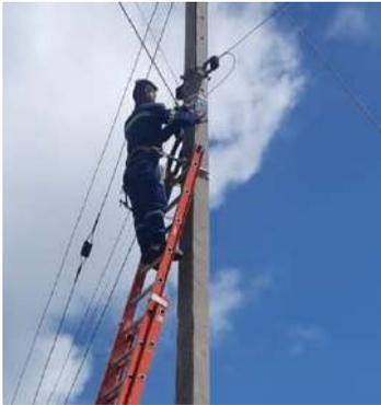
**Figura 48-3:** Instalación de herrajes
