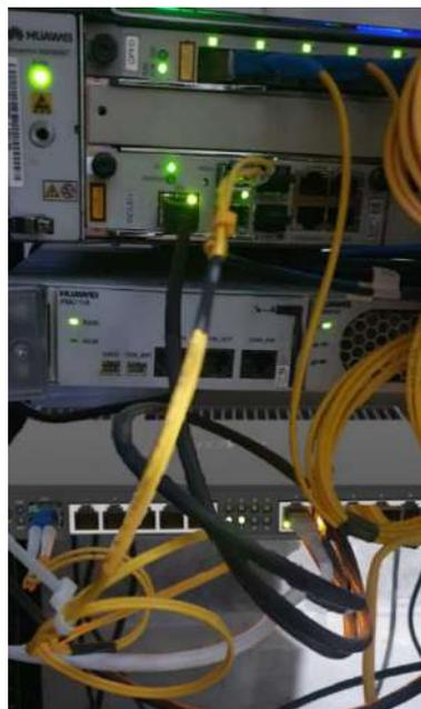
**Figura 42-3:** Conexión Router Mikrotik y OLT
