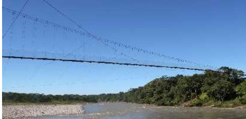
Figura 9-2: Puente colgante “Toni el Suizo” Realizado por: Cerda, L.; Taípe, J. 2021
