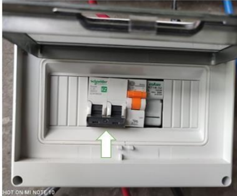
Figura 7-3: Breaker 20A reflectores Realizado por: Reyes, Paulo; 2021
