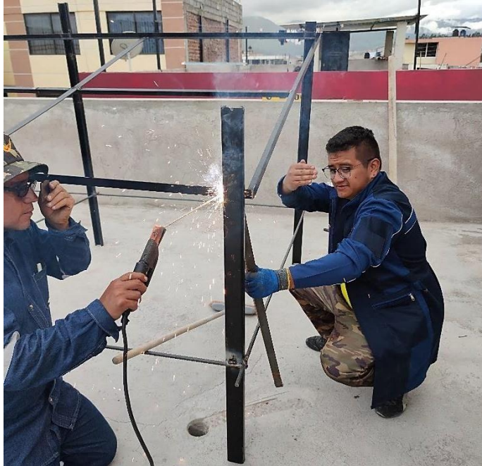
Figura 17-2: Ensamble de la estructura de paneles Realizado por: Reyes, Paulo; 2021
