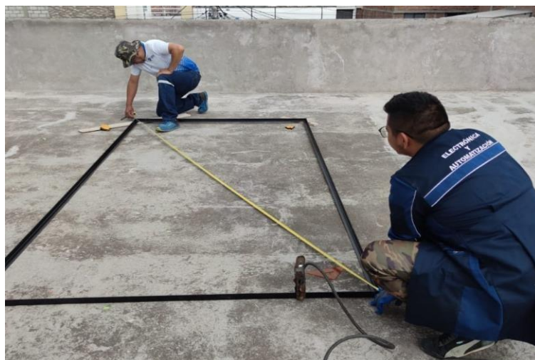
Figura 16-2: Ensamble del marco de la estructura Realizado por: Reyes, Paulo; 2021
