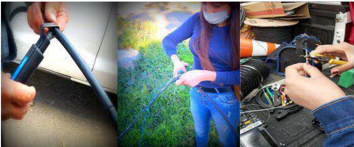
Figura 1: Preparación del cable de Fibra Óptica.
