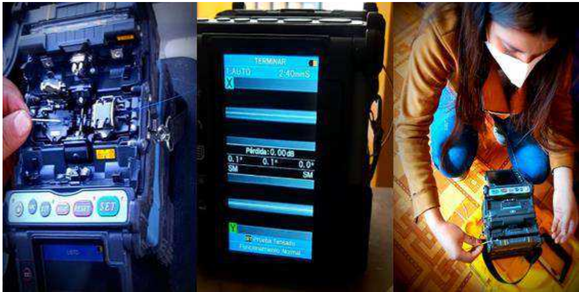
Figura 2: Proceso de Fusión de la Fibra Óptica.
