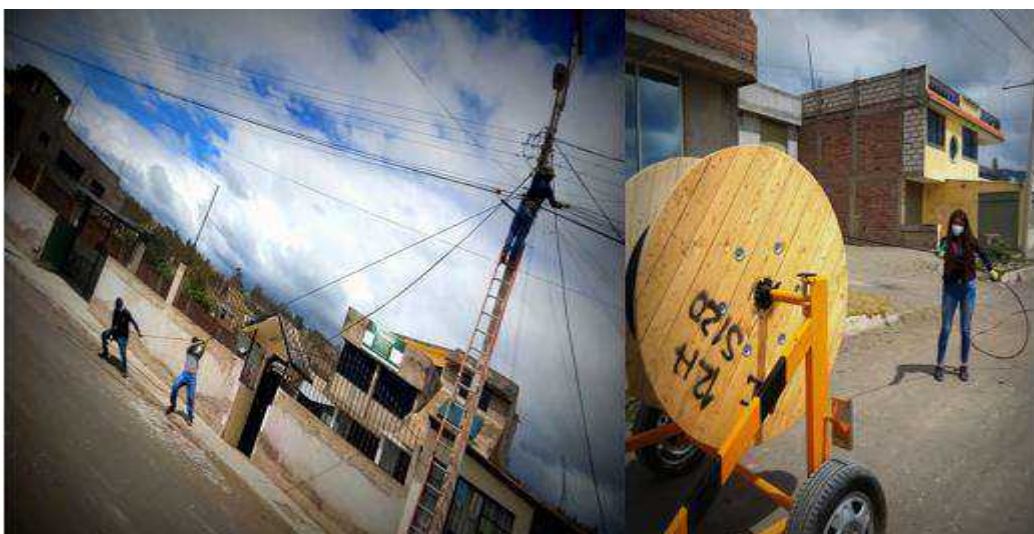
Figura 11: Templamiento del cable y desenvolvimiento de la fibra del carrete
