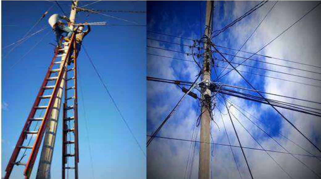
Figura 10: Colocación de herraje tipo A y preformado
