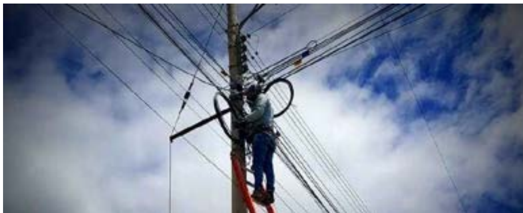
Figura 12: Sujeción de reservas de fibra.
