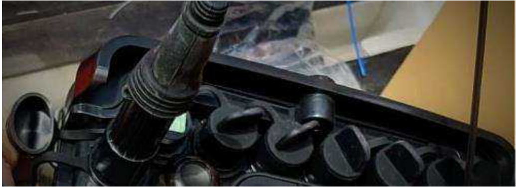
Figura 29: Colocación del conector mecánico en el puerto de la NAP
