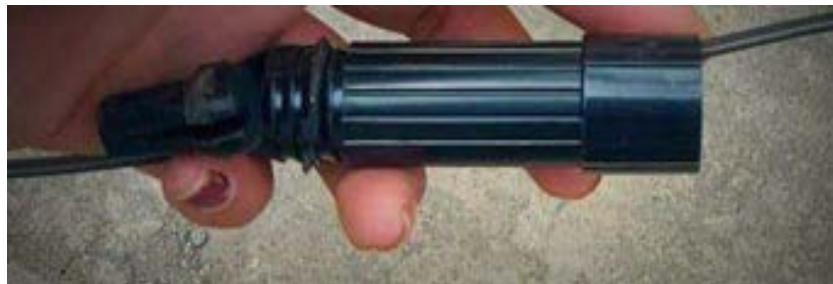
Figura 27: Colocación del adaptador en el cable Drop
