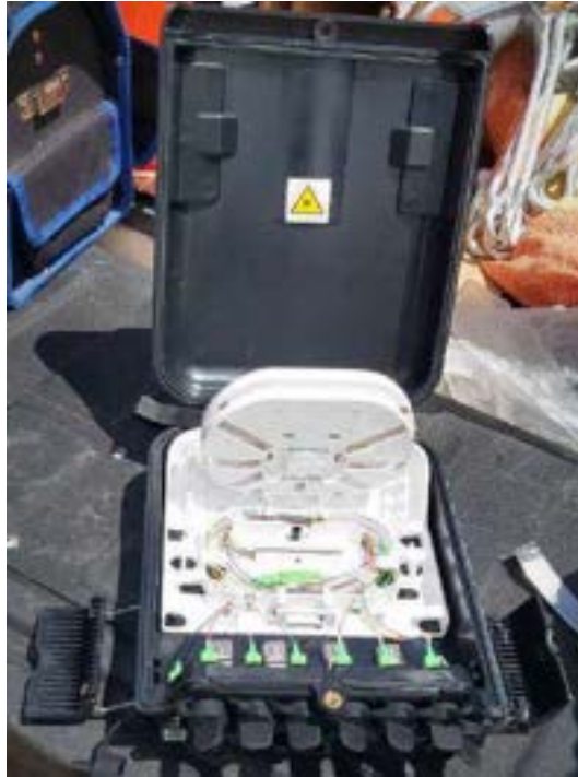
Figura 20: NAP con splitters conectorizados
