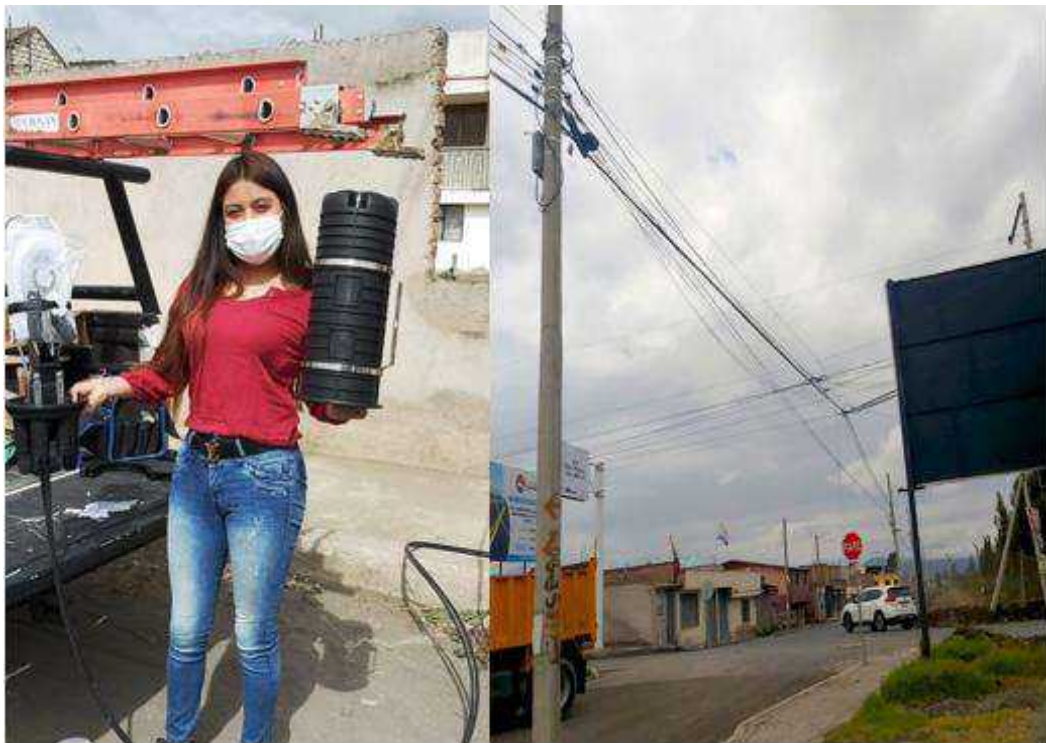
Figura 17: Instalación de la Manga Domo
