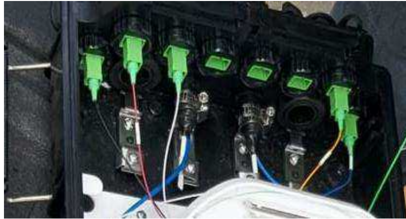
Figura 22: Sujeción del elemento de tracción a la NAP
