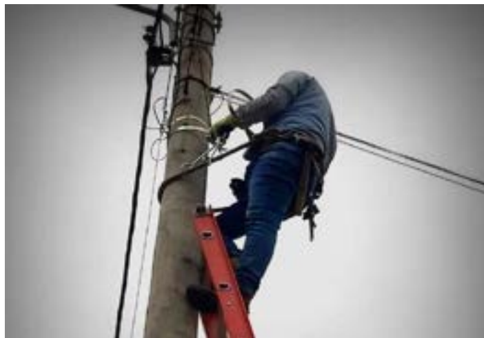
Figura 9: Colocación de abrazaderas en el poste
