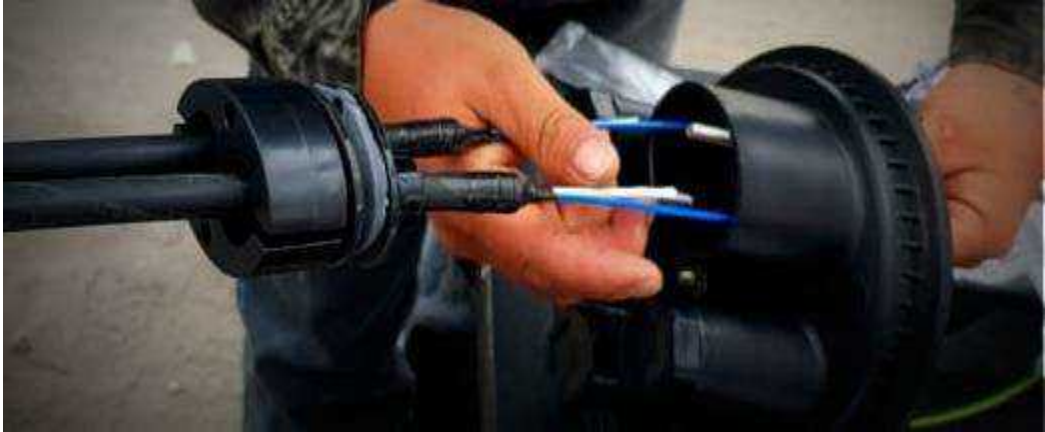
Figura 14: Ingreso de los buffers en la manga
