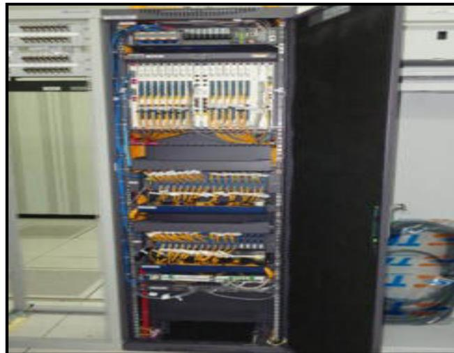
**Figura 9-1.** Equipo Terminal Óptico
