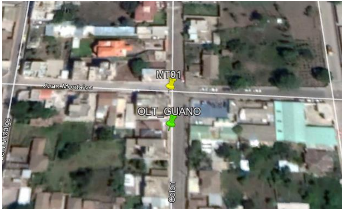
Figura 0-50: Lugar de instalación del equipo OLT.
