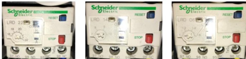
Figura 6-2: Relé de sobrecarga térmica TeSys LRD Schneider
