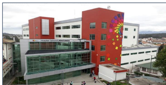
Ilustración 1-2: Hospital General Latacunga
