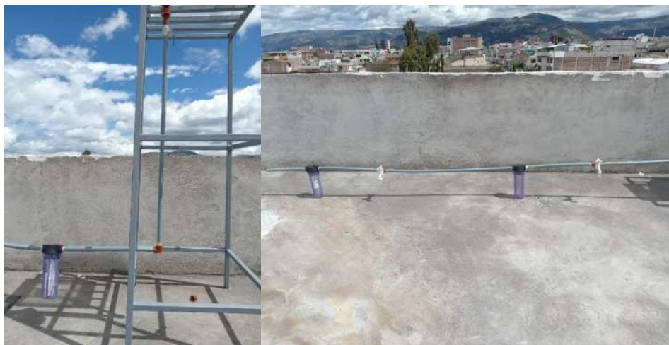
Ilustración 4-8: Construcción del sistema de tuberías y filtros
