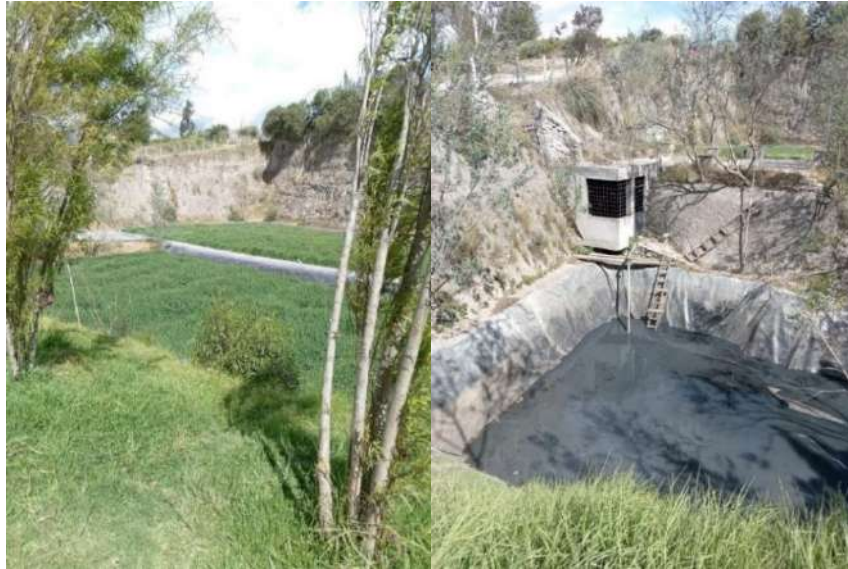
Ilustración 4-15: Planta de tratamiento de San Vicente de Lacas
