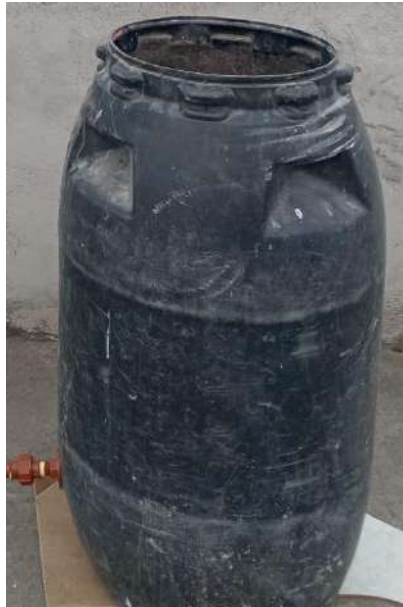
Ilustración 4-3: Tanque de reserva de agua
