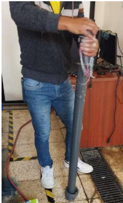
Ilustración 3-8. Limpieza de tuberías PVC
