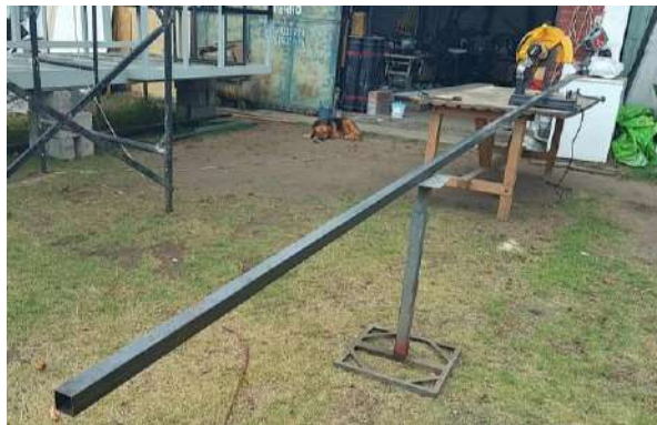
Ilustración 3-74: Corte de tubo de tubo en tronzadora.
