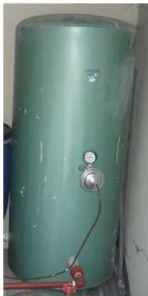
Compuesto por acero inoxidable, altura de 2m x 0.80 m de diámetro, trabaja conjuntamente con la bomba, es decir que cuando existe una baja de presión enciende automáticamente a la bomba esto sirve para el trasportar del agua que se encuentra en la cisterna. Mantiene una presión máxima de 100 psi y una mínima de 20 psi.
