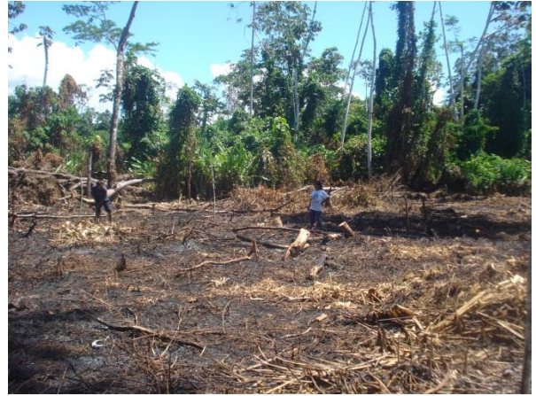
Fotografía 8: Segunda visita de la limpieza del terreno.
