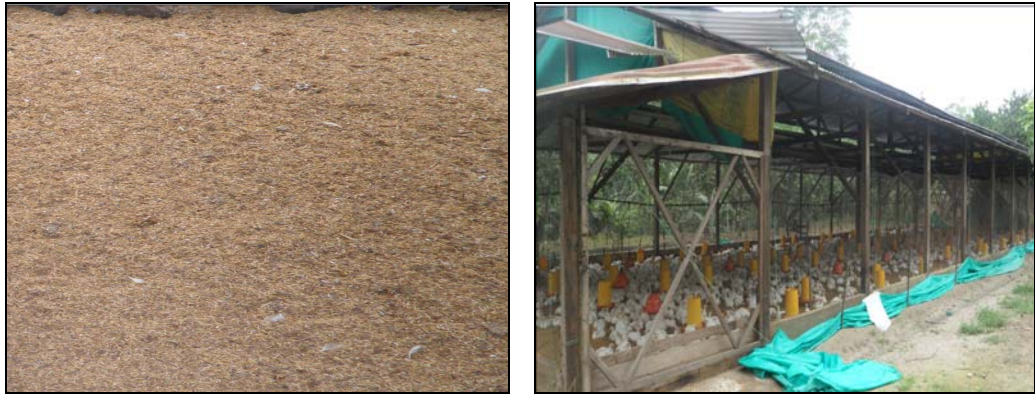
FOTOGRAFÍAS No. 4 – 5 PISO DE TIERRA RECUBIERTO POR UNA CAMA DE CASCARILLA DE ARROZ O TAMO, PAREDES CON VIGAS DE MADERA Y MALLA METÁLICA, SISTEMAS DE CORTINAS MANUALES (SACOS DE YUTE)
