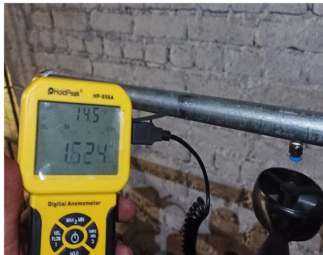
Ilustración 3-10: Toma de velocidad de salida del gas pobre.
