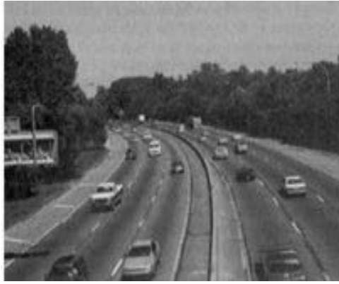
Ilustración 2-3: Nivel de servicio C
