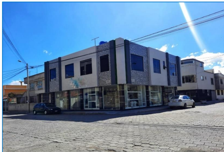
Ilustración 5-3: Establecimiento Caja de Ahorro Punín
