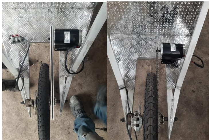
Figura 4-3: Alineación e instalación de cadena
