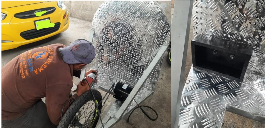
Figura 5-3: Perforación y colocación de caja contenedor de baterías.
