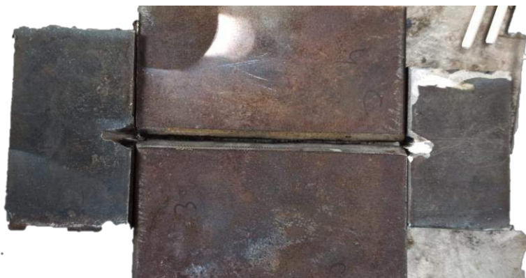
Ilustración 4-4: Colocación de placas antes de realizar el apuntalado
