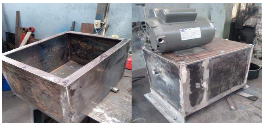
Ilustración 16-3: Construcción del depósito de aceite
