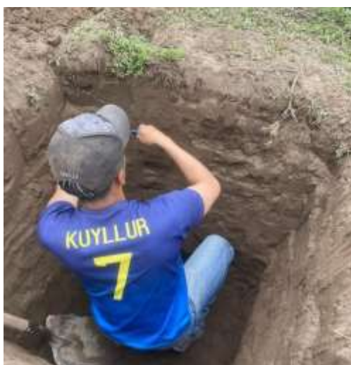
Ilustración 3-4: Realización de calicatas.
