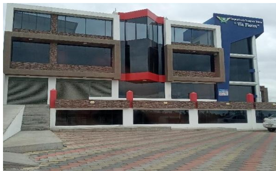
Ilustración 6-2: Sede la Cooperativa Vía Flores
