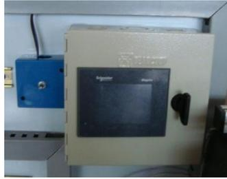
**Figura III.19:** Montaje del HMI y del control de velocidad del motor
