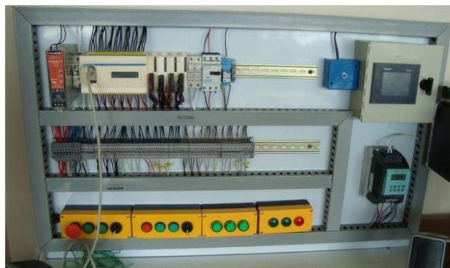
**Figura III.17:** Disposición de los equipos en el panel de control
