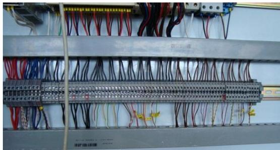
**Figura III.21:** Conexión de las borneras
