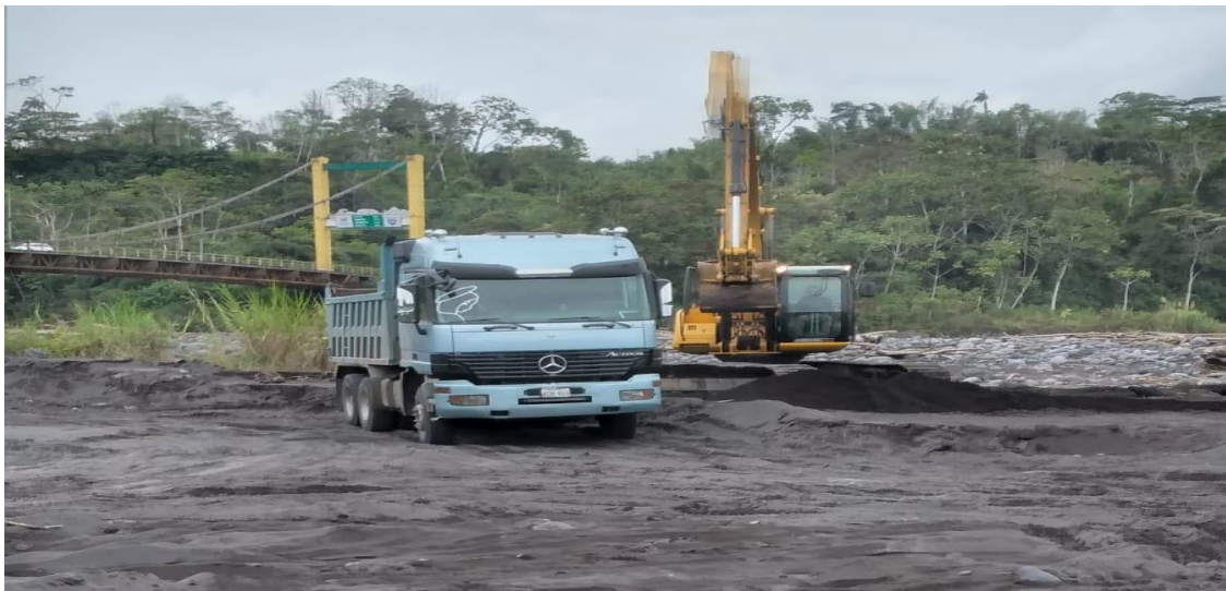
Ilustración 5-2: Cargado de material
