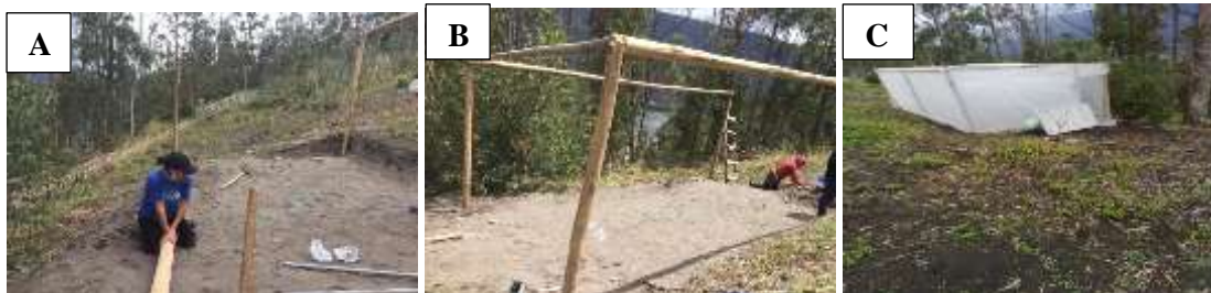
Ilustración 2-3: A. Delimitación del área B. Armado de la infra estructura C. Cubrimiento con plástico de invernadero del vivero temporal.
