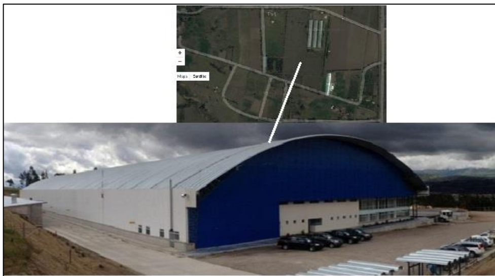
Figura 2-3: Instalaciones de la empresa CIAUTO Ambato
