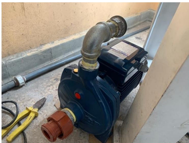
Ilustración 1-4: Proceso de instalación de la nueva electrobomba centrífuga y nueva tubería.
