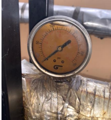
Ilustración 5-3: Manómetro averiado
