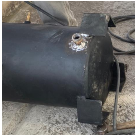
Ilustración 3-4: Proceso de reparación del tanque de diesel
