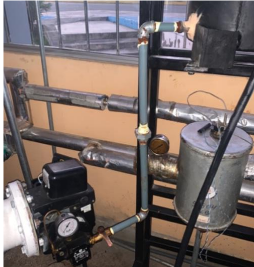
Ilustración 4-4: Tubería recién instalada de salida del Diesel desde el tanque hacia el quemador
