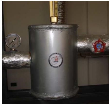
Ilustración 11-2: Cámara de expansión
