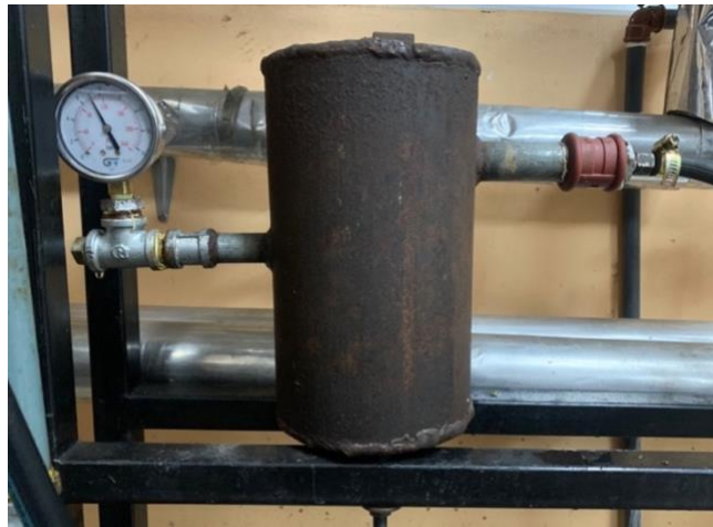
Ilustración 6-3: Prueba hidrostática de la cámara de expansión a 106,94 psia
