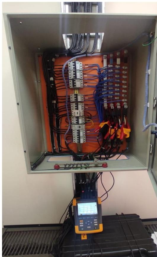
5. Verificamos con una pinza amperimétrica si los valores del analizador de energía son los correctos
