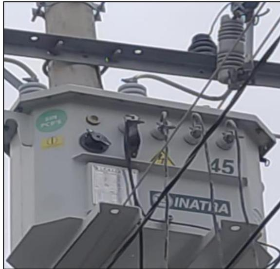
**Figura 3-3:** Transformador convencional
