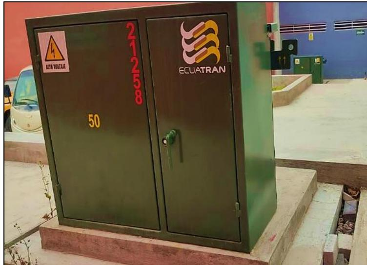
**Figura 4-3:** Transformador Padmounted de 50 kVA
