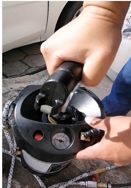
Presurización del Equipo previo a instalación.
