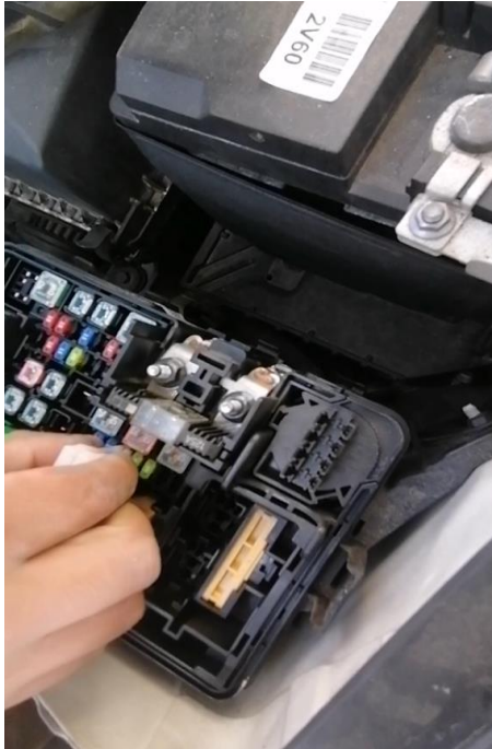
Extracción del fusible de la bomba de combustible.
