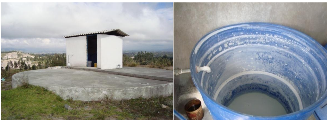
Figura 17. Toma de agua para la mezcla, desinfección actual San Vicente de Lacas
