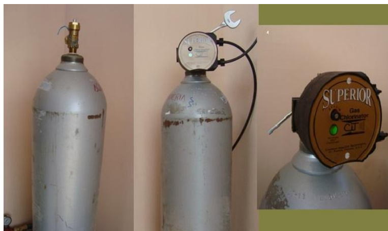
Figura 64. Instalación del clorinador
