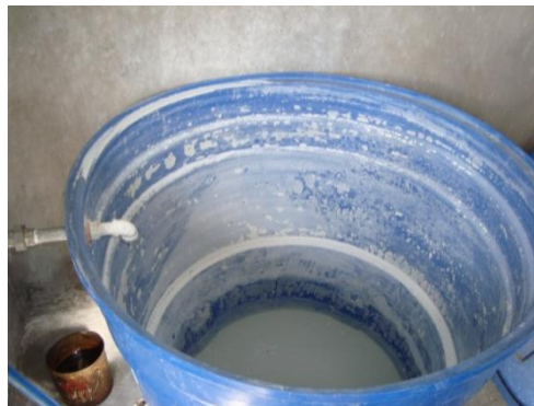
Figura 20. Sedimentación de hipoclorito de calcio. Desinfección actual en San Vicente
