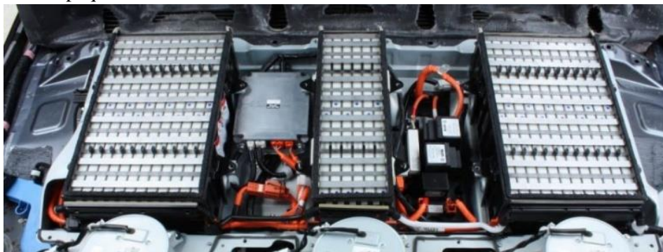
Ilustración 6-2: Batería de alta tensión
