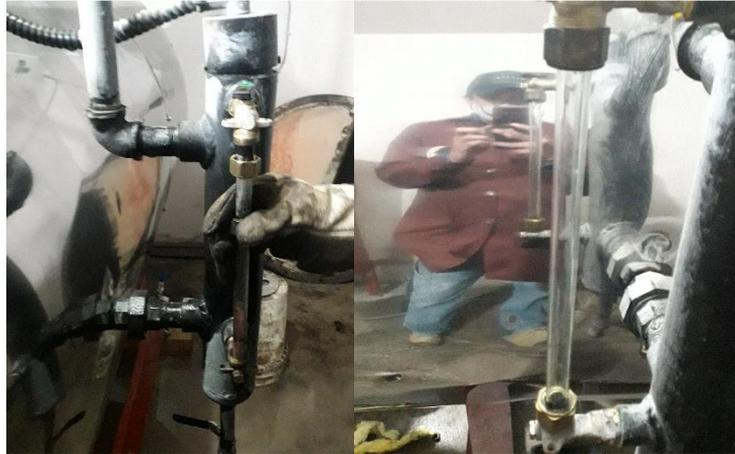
**Figura 11-3:** Limpieza y cambio de empaques del nivelador
