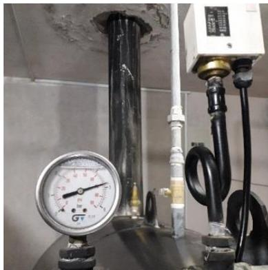
**Figura 6-3:** Presostato y manómetro de control
