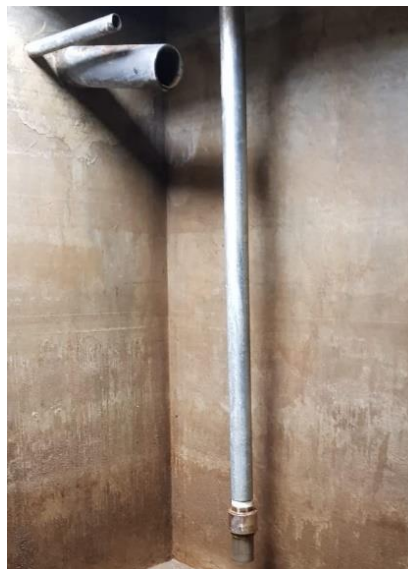
Figura 13-3: Cambio de la línea de succión de la cisterna.
