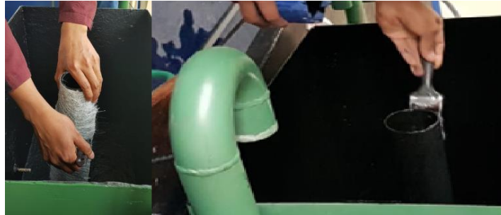
Figura 14-3: Aplicación de fibra de vidrio al tanque de agua.
