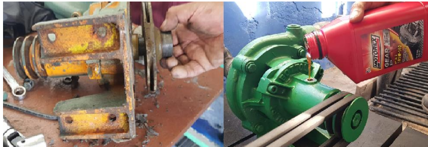
Figura 17-3: Mantenimiento preventivo a la bomba centrífuga.
