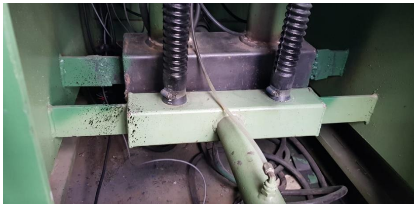
Figura 15-3: Pintado del tanque reservorio de agua.
