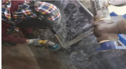
Figura 16-0: Retiró de pintura sobrante
