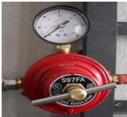
Figura 10-0: Regulador de presión de gas
