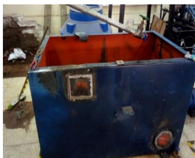
Figura 4-0: Cubrimiento de agujeros en el tanque reservorio
