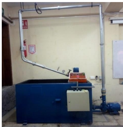
Figura 5-0: Montaje del panel de control
