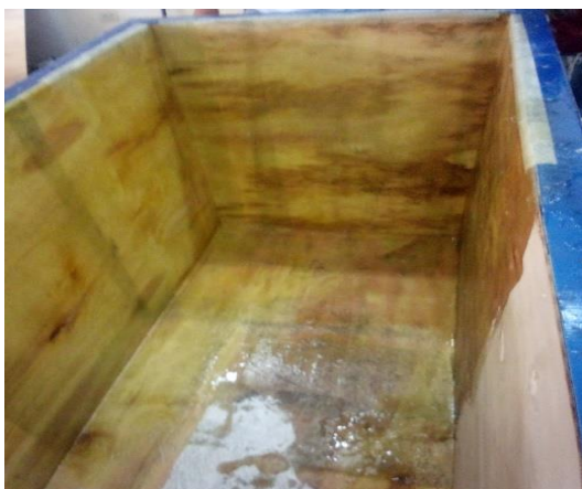
Figura 19-0: Aplicación de resina y fibra de vidrio
