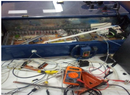
Figura 26-0: Desmontaje de los elementos del tablero
