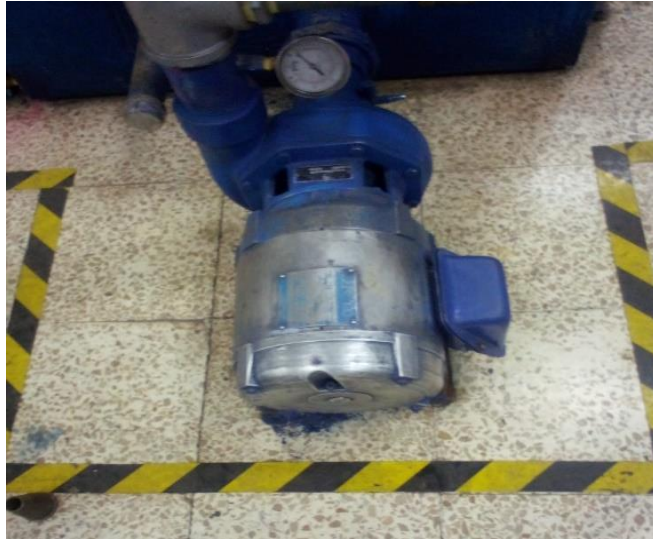
Figura 22-0: Retiró de pintura de la bomba centrífuga
