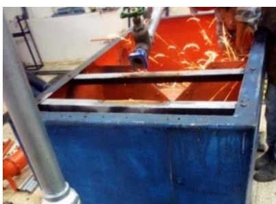
Figura 3-0: Retiró del vertedero triangular del tanque reservorio
