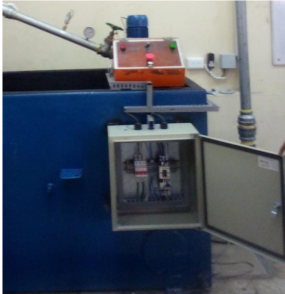
Figura 4-0: Montaje del panel de control
