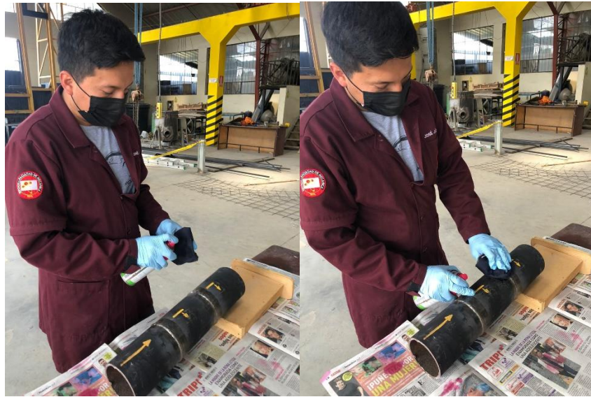
Figura 9-3: Limpieza del cordón de soldadura con cleaner
