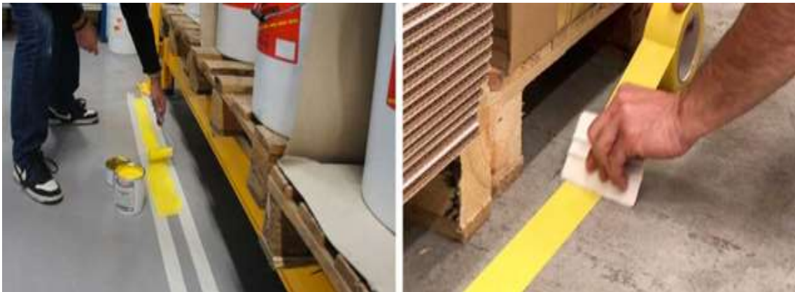
Figura 45-3: Colocación de la cinta adhesiva
