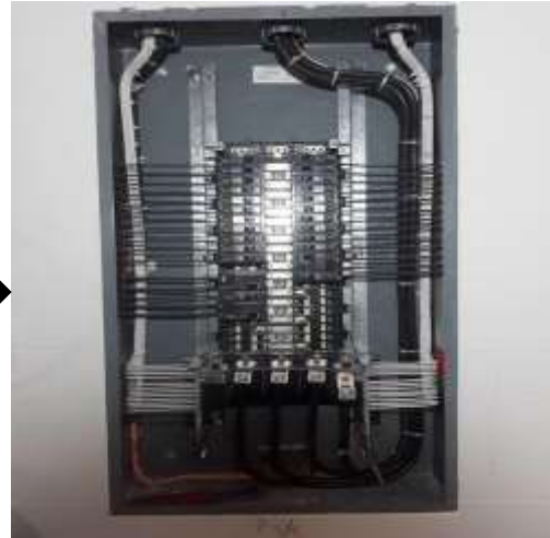
Figura 36-3: Etiquetas informativas y disposición de los conductores
