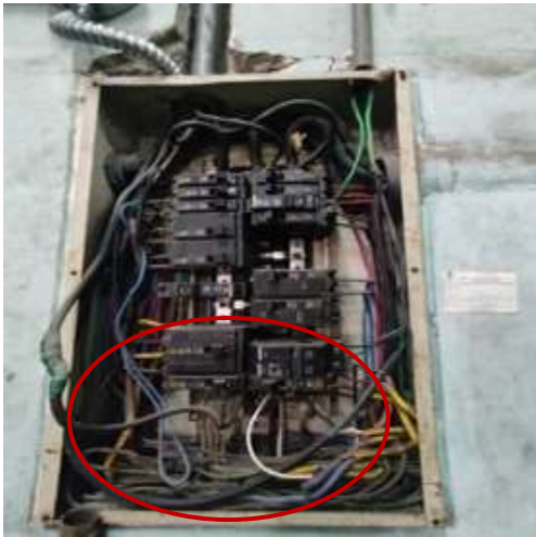
Figura 37-3: Etiquetas informativas y peinado de tableros eléctricos
