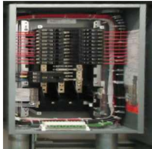
Figura 37-3: Etiquetas informativas y peinado de tableros eléctricos
