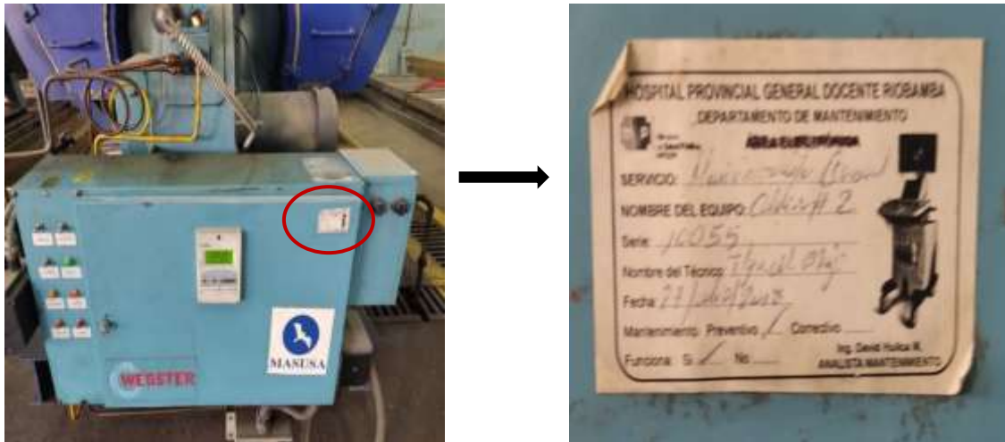
Figura 8-3: Codificación del caldero piro tubular
