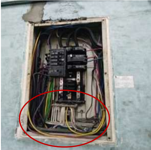
Figura 36-3: Etiquetas informativas y disposición de los conductores
