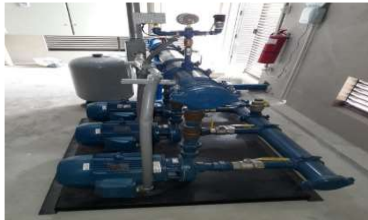
Figura 17-3: Sistema de presión constante
