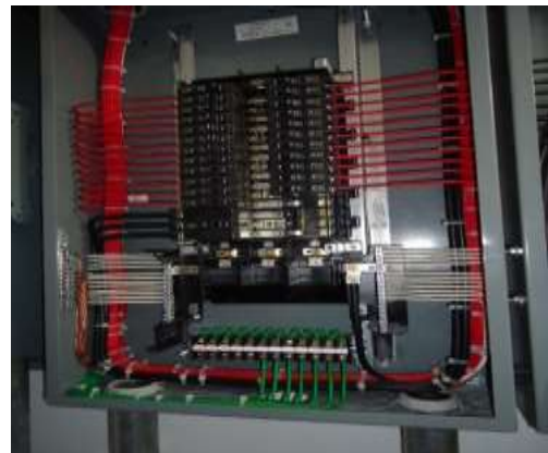
Figura 38-3: Etiquetas informativas y peinado de tableros eléctricos
