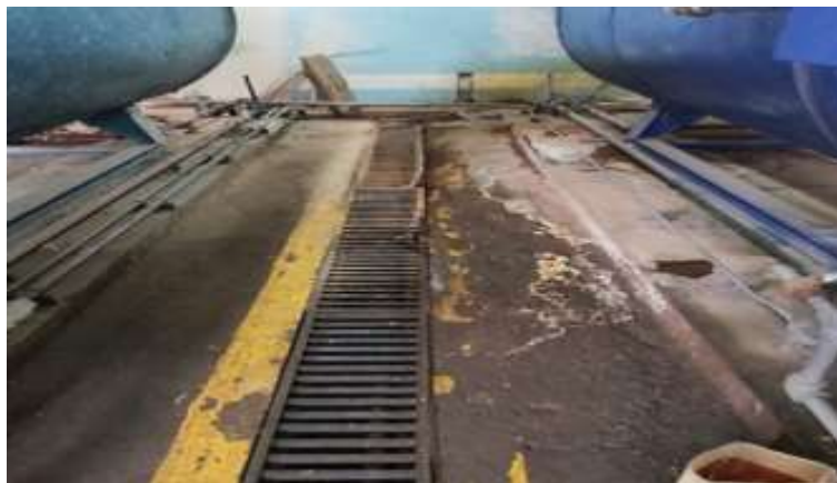
Figura 42-3: Pintura líneas divisorias
