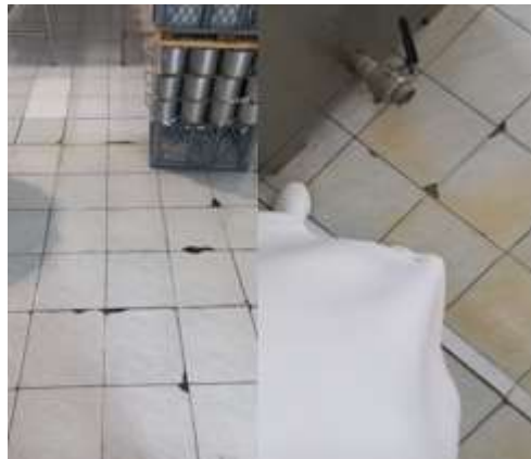
Imagen 4: gritas en la planta de producción de quesos
