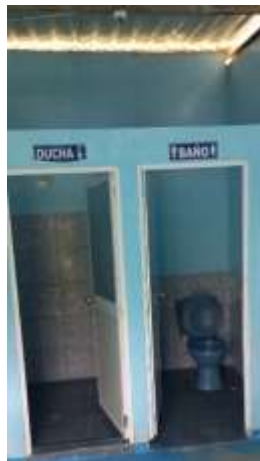
Imagen 10: Instalaciones sanitarias unisex
