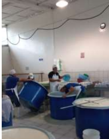
Imagen 9: cable colgado sobre el área de producción de alimento (quesos)
