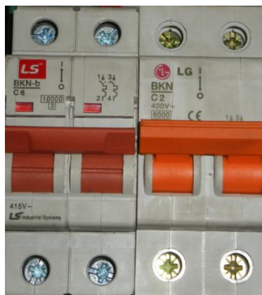
Figura 10: Breaker automático.
