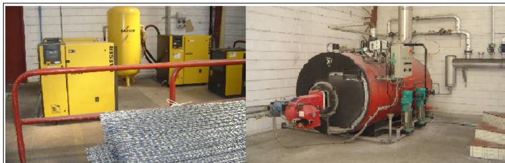
Figura 3.1: Línea de generación de aire y vapor
