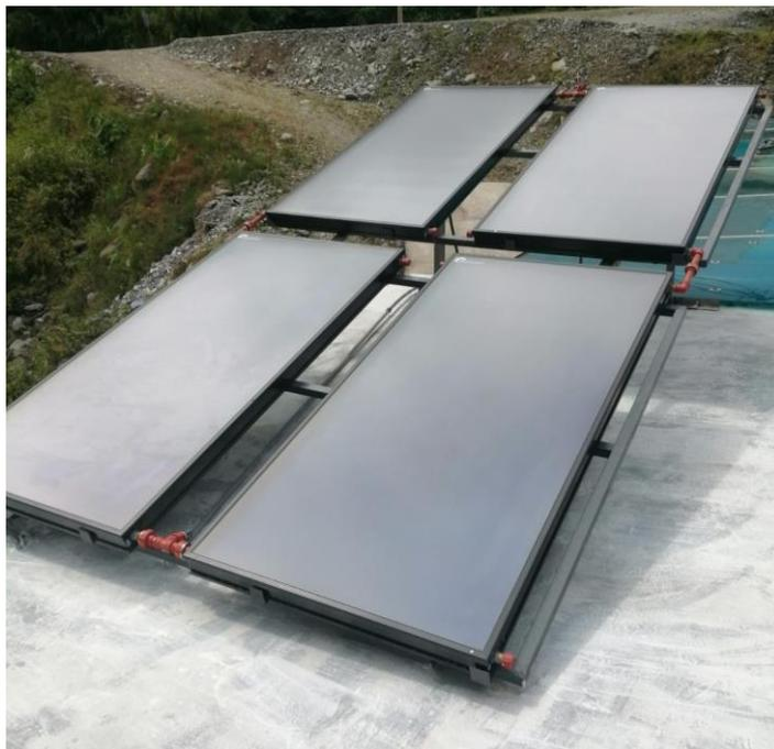
**Ilustración 4-4:** Instalación de 4 paneles solares de placa plana.
