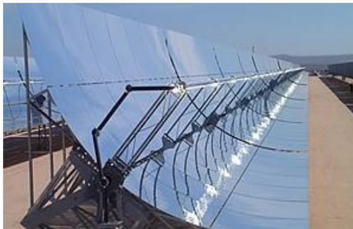
**Ilustración 4-2:** Concentrador solar cilíndrico parabólico
