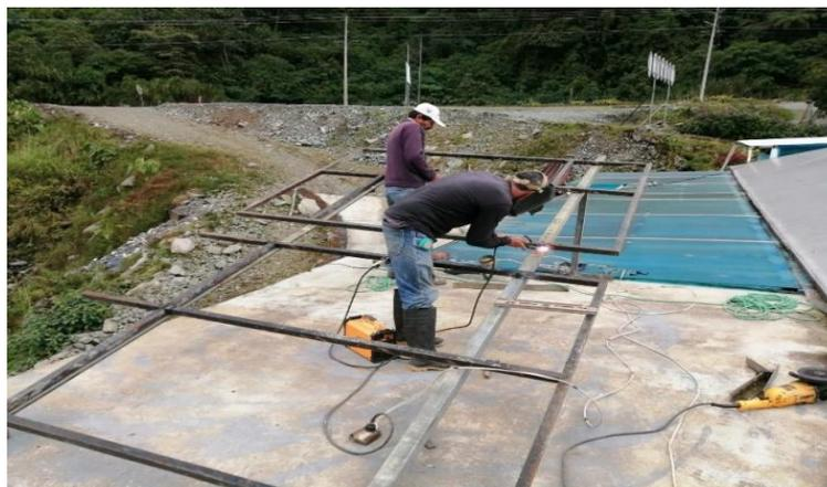
**Ilustración 2-4:** Construcción de estructura para soporte de 4 paneles solares de placa plana.
