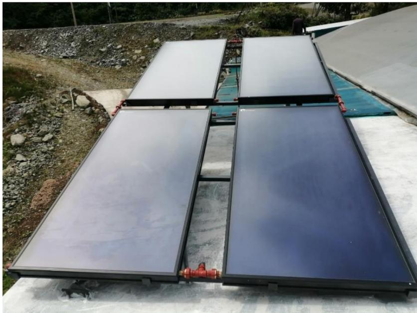
**Ilustración 11-4:** Instalación total de sistema solar térmico de placas planas
