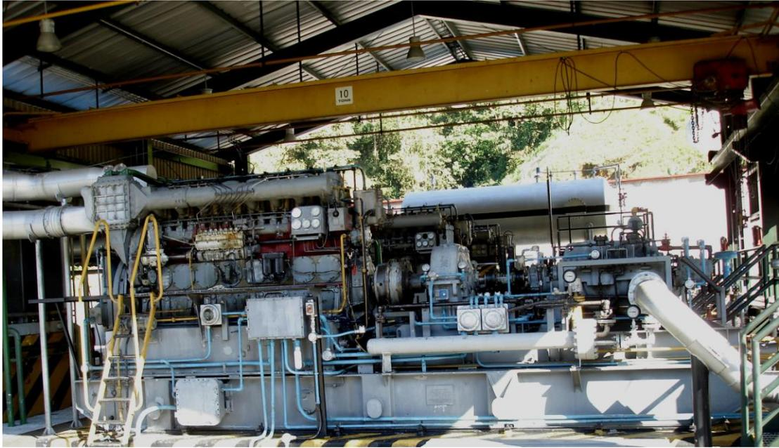
**Figura 3.6:** Grupo de Bombeo (Motor-Incrementador-Bomba)
