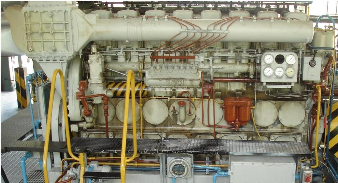
**Figura 3.9:** Motor de Combustión Interna TDB-440 8K
