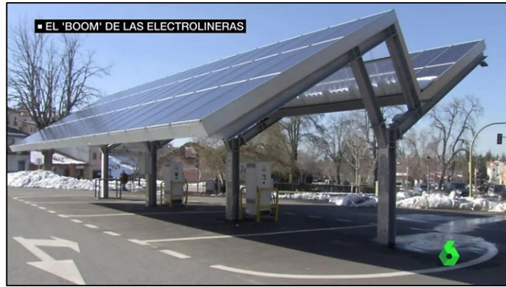
Figura 14-3: Electrolinera con fuente energética a panel solar. Fuente: LaSexta.com
