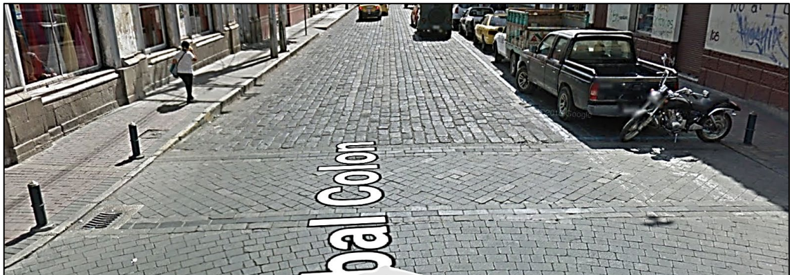
Figura 10-3: Paso piedra-adoquín, Intersección calle Colón y Primera Constituyente.
