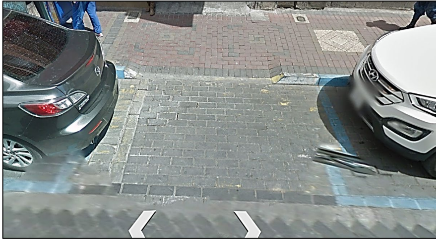
Figura 9-3: Patrón de ubicación del adoquín rectangular en estacionamientos.
