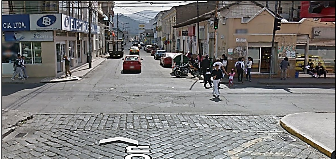
Figura 11-3: Paso piedra-asfalto, Intersección calle Olmedo y Colón.
